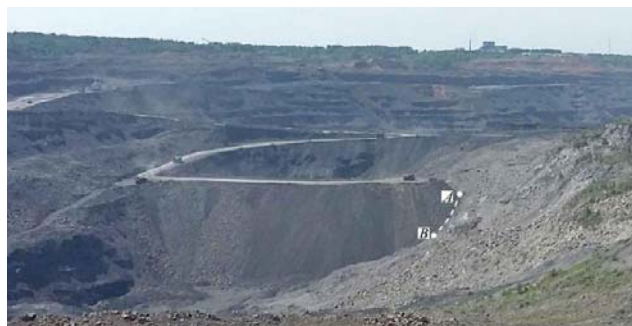
Рис. 11. Отсыпка распорного контрфорса для стабилизации оползня в районе инженерно-геологической зоны № 13
