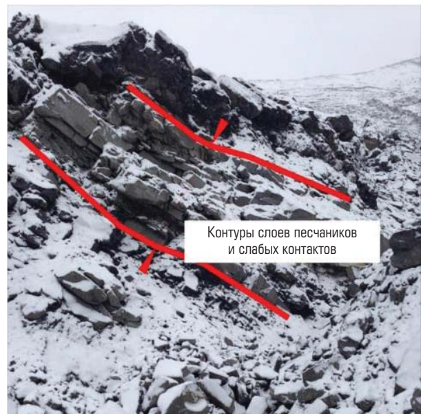
Рис. 9. Разностные слои песчаника углистых аргиллитов и слабых контактов, вынесенные в нижнюю зону обрушения горного массива на участке № 3 разреза «Черниговец» [15]
